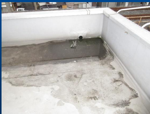
屋上ドレン(漏水箇所直上)
